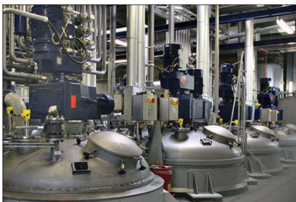
Мал. 71. Хімічні реактори в заводському цеху
