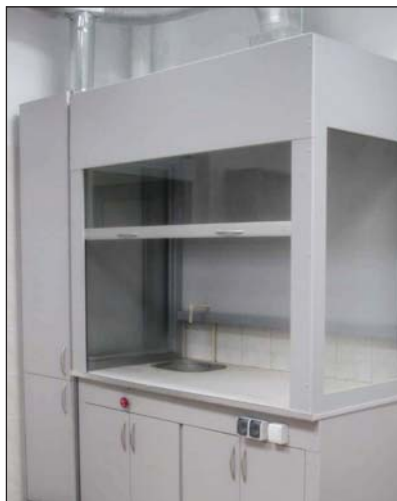
Des. 8. Nișă de ventilație
