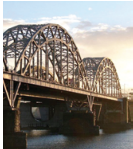
Дарницький міст через р. Дніпро
