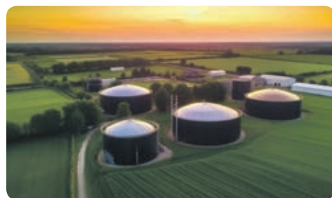
Мал. 41.8. Виробництво біогазу — суміші метану, водню та інших горючих газів — із відходів рослинництва та тваринництва
